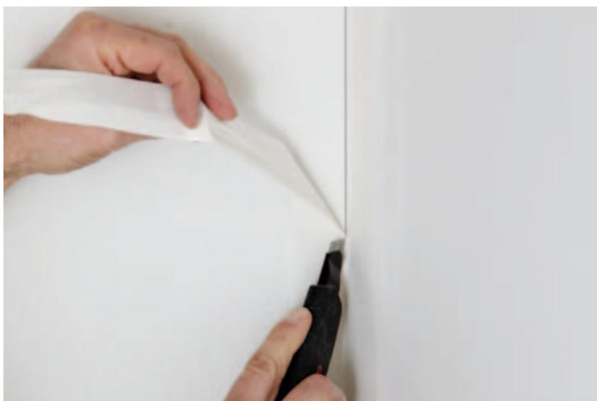
5. Odvečni del Rigips TrennFix traku se odreže.
