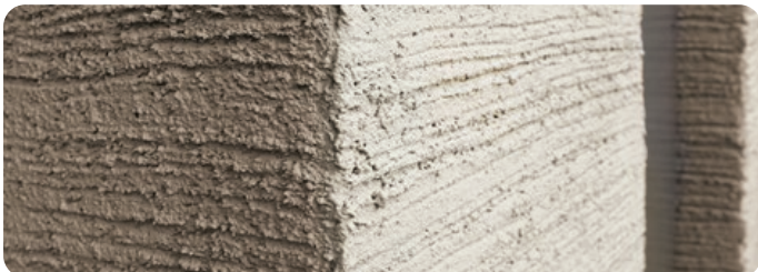
tehnika obdelave z omelom
