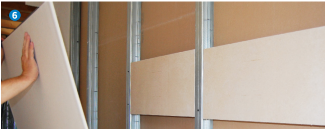
6 Namestitov prvega sloja plošč.
